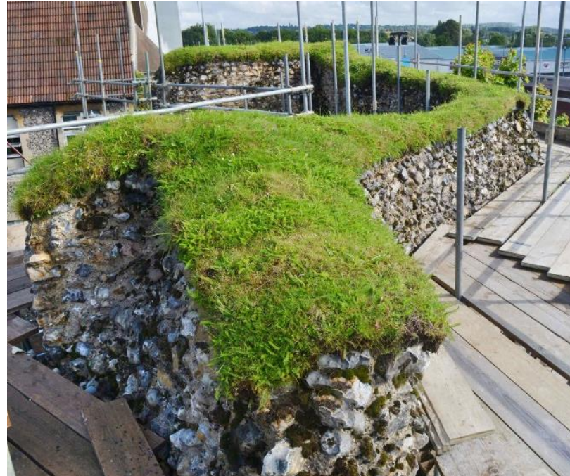
Muratura del transetto sud delle rovine dell'abbazia di Reading ( Berkshire , UK) prima e dopo l'intervento di "soft capping"
